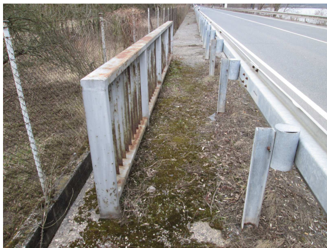
Nánosy, nečistoty na římse.
