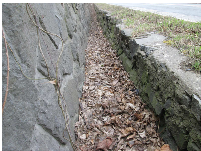
Lokálně vydrolené spáry.
