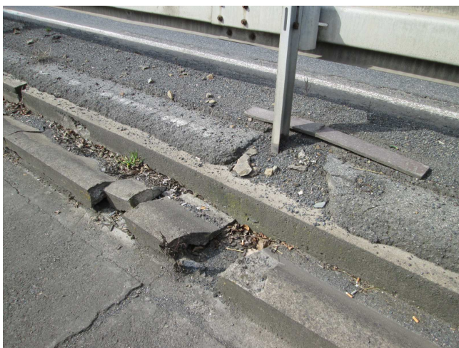
Rozpad předsazeného řlabu.
