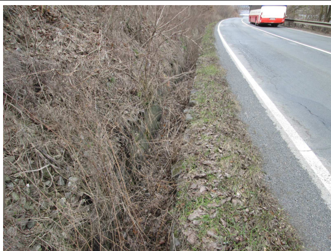
Částečně zanesený příkop.
