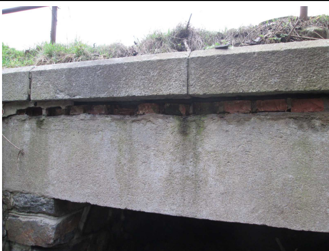
Rozpad cihel pod římsou vpravo.
