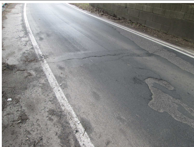
Dilatační spáry prokreslené do vozovky.
