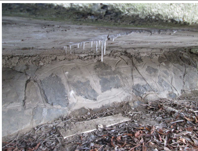
Konzola. Trhlina, silné průsaky, výluhy, krápníky.
