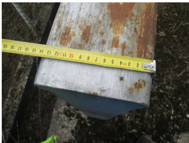
Koroze zábradlí.
