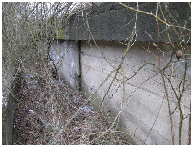
Stopy průsaků dilatační spárou. Nazelenalý povlak, biologické napadení.
