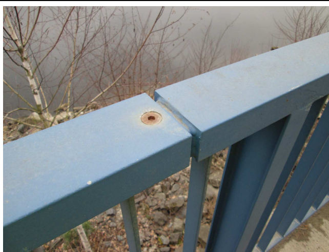
Zábradlí. Povrchová koroze šroubů. Nátěr matovatí.
