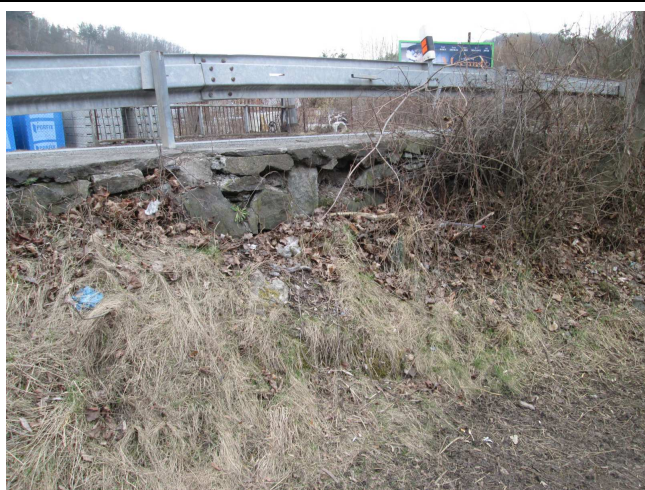
Masivně vydrolené spáry, rozvolněné zdivo, část kamenných bloků chybí.
