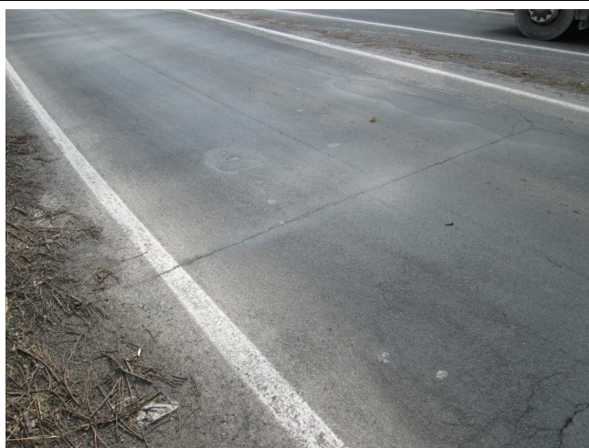
Dilatační spáry prokreslené do vozovky.
