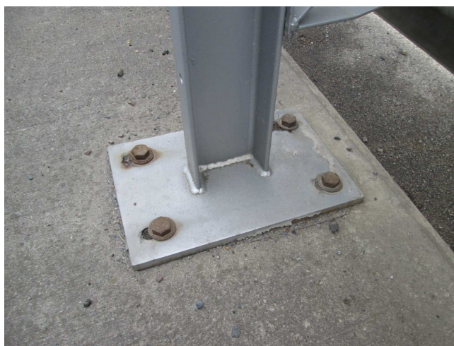
Svodidlo vlevo. Povrchová koroze kotevních šroubů. V menší míře koroze patních desek.
