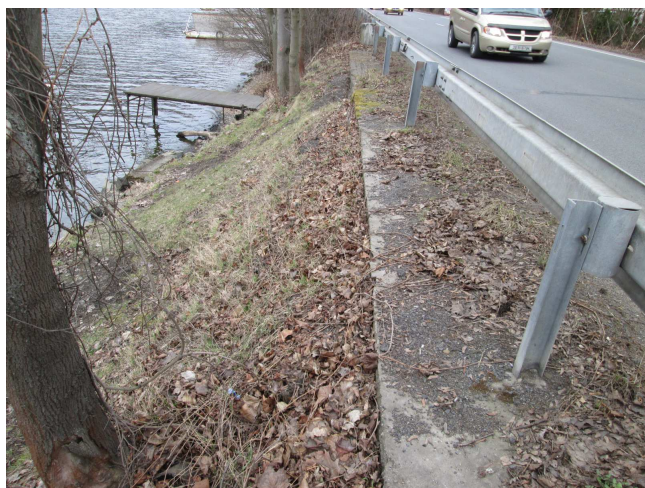
Nečistoty, nánosy na římse.
