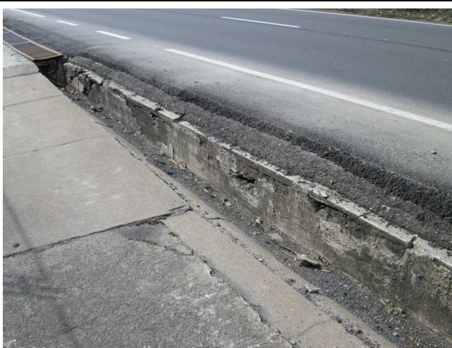
Výrazně převýšená vozovka. Masivní degradace betonu.
