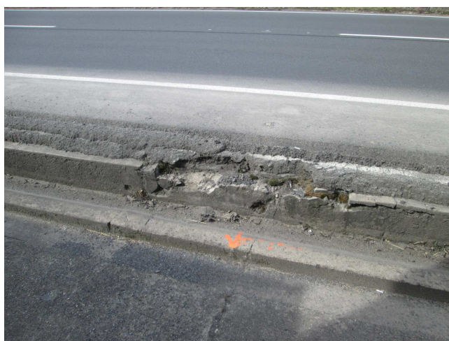
Masivní degradace betonu, rozpad.
