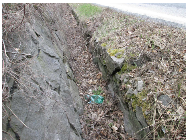
Lokálně vydrolené spáry.
