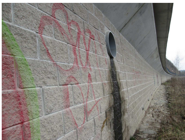
Přetoky vody z kanalizace na líc zdi. Povrch znečištěn. Posprejováno.
