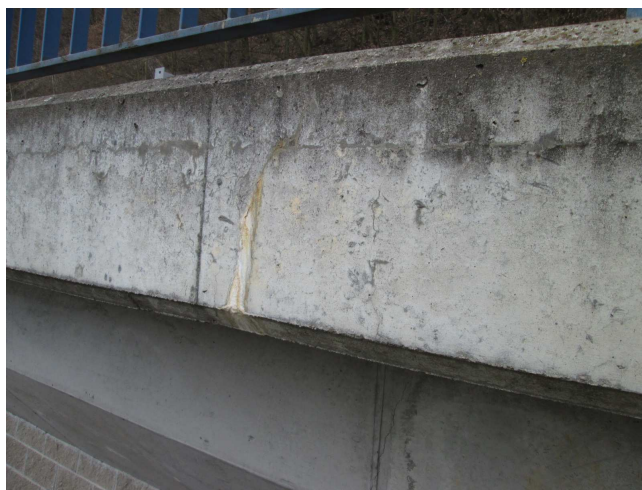
Bok římsoy. Ojedinělé stopy průsaků trhlinami. Povrch znečištěn.
