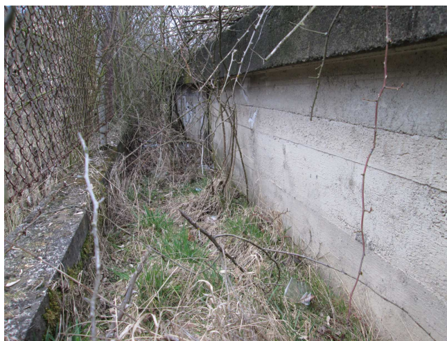
Pohled proti směru staničení. Ojedinělé výkvěty solí.
