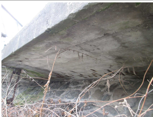
Podhled konzoly. Stopy zatékání. Bionapadení.
