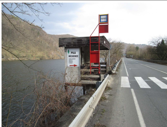
Přístřešek autobusové zastávky uložený na opěrné zdi.
