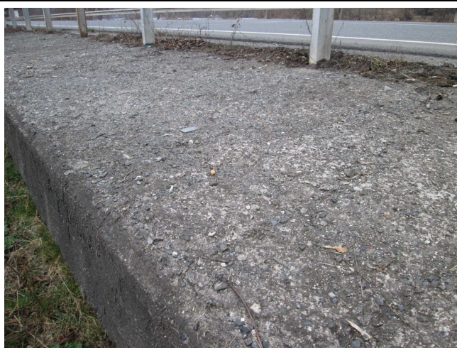
Degradace betonu římsy.
